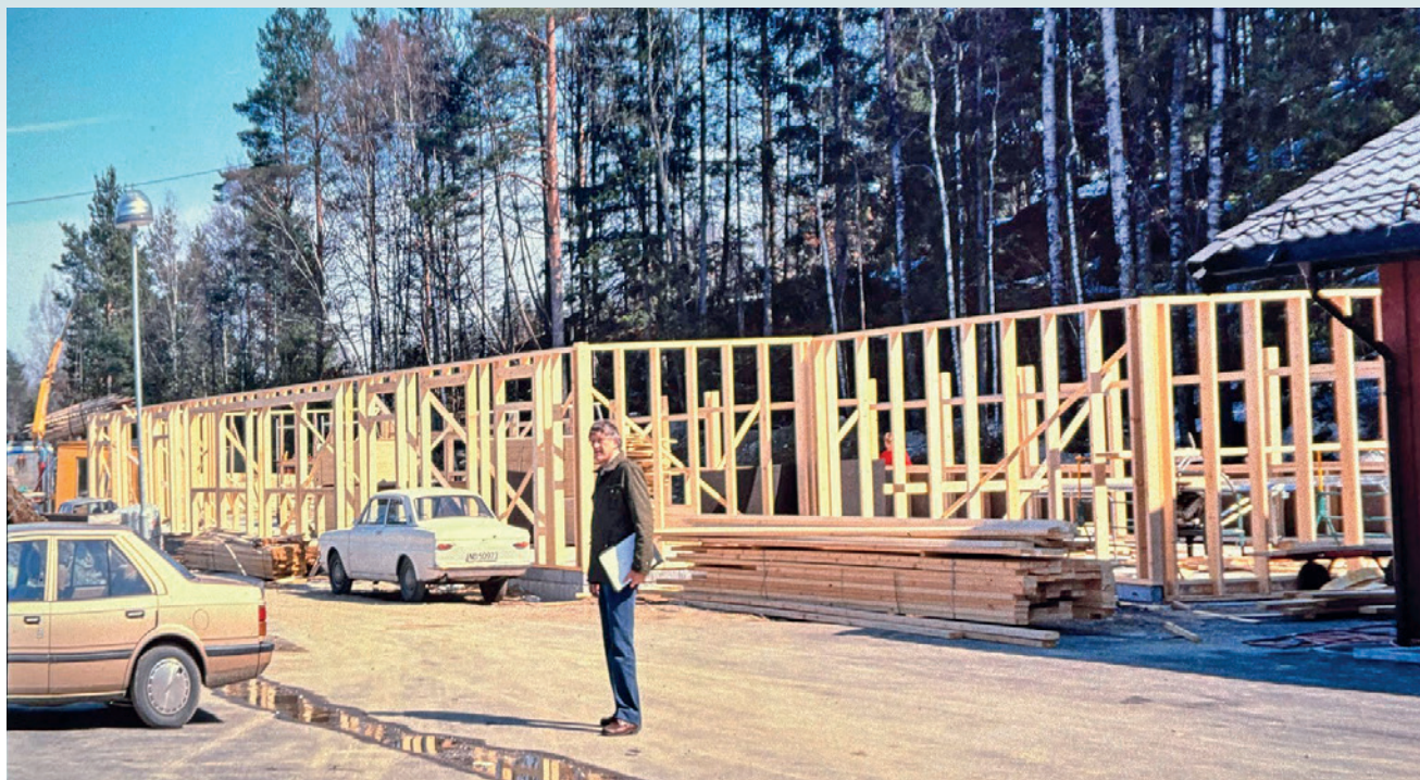
Rektor Sverre Brændhagen inspiserer byggingen av den østre klasseromsfløyen, 1985. Den nye skolen var «sprengt» allerede fra starten, og dette var andre byggetrinn, ferdig høsten 1985.
